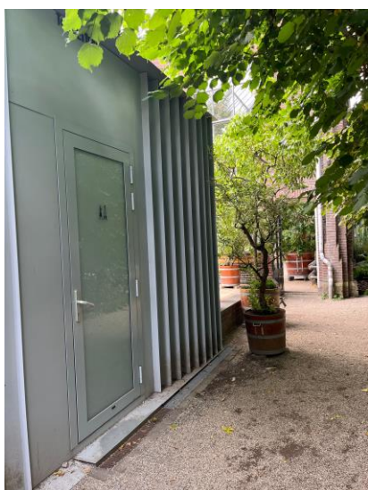
Toiletgebouw bij de Palmenkas
